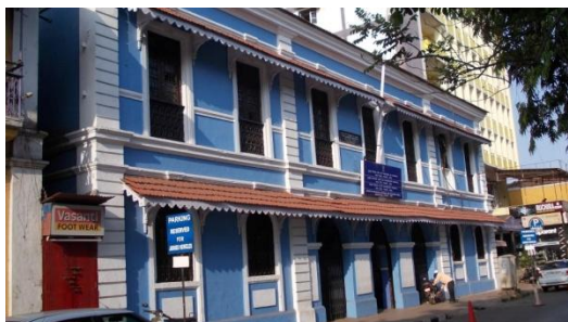
Edifício do antigo tribunal de comarca de Pangim (foto LCO)
